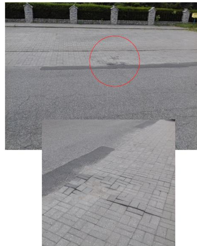
ul. Włocławska przy parkingu przykościelnym
