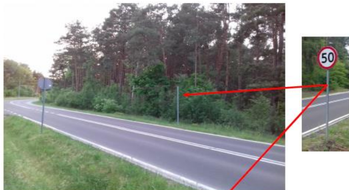
ul. Włocławska brak drogowego znaku zakazu B-33
